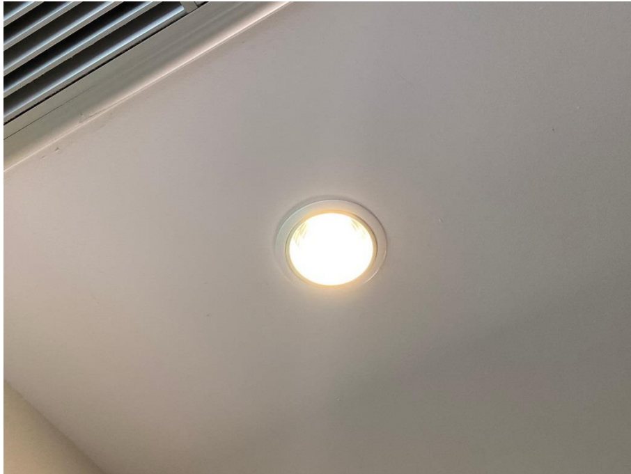
ภาพที่ 5 แสดงหลอดไฟประหยัดพลังงาน (หลอดตะเกียบ)
