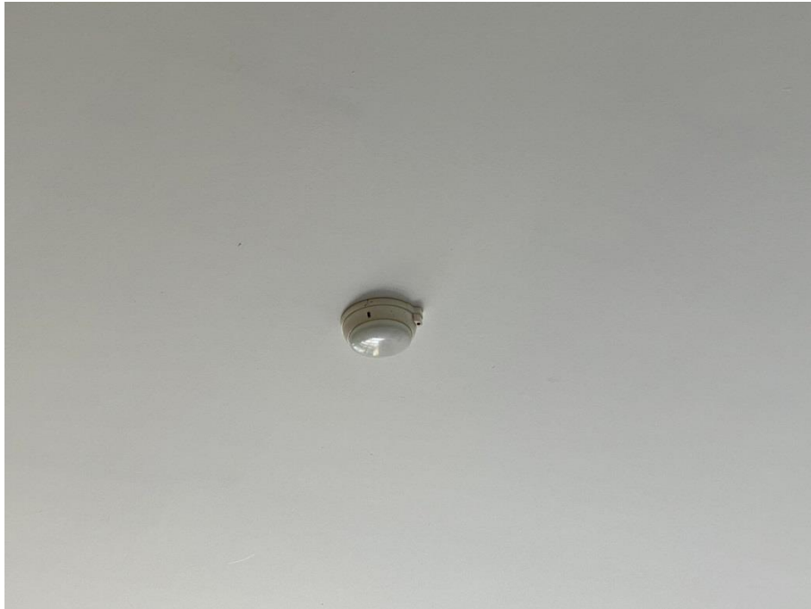
ภาพที่ 7 แสดง Heat Detector ภายในห้องพัก
